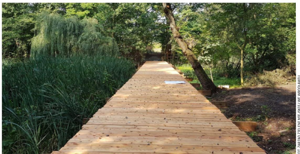
Drewniana kładka wykonana na jednym z pierwszych etapów rewitalizacji parku Swojczyckiego
